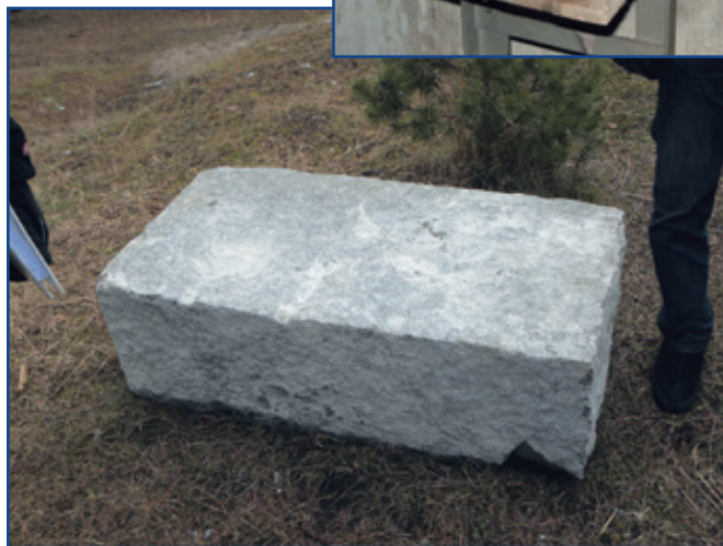
Kvaderblock. Stenblock som var exakt rakhuggen. Stenen lades i ett tätt skikt på taket i värnet för att dämpa detona- tionen vid träff av granater.
