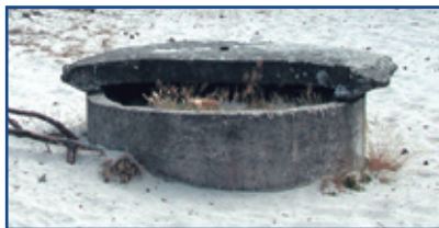
Bild på skyttevärn som man även kan se vid den östra pirarmen på Östersjösidan. Taket fungerar som splitterskydd för skyttesoldaten.
