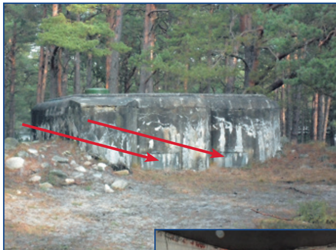
Kulsprutevärn modell 1. På bilden syns de igen- murade embressyrerna (Där kulsprutornas pipor stacks ut).
