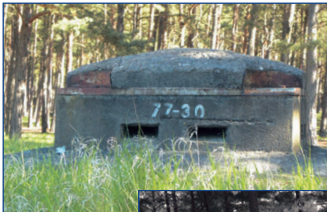
Ventilationshuv på skyddrum av modell SK24.
