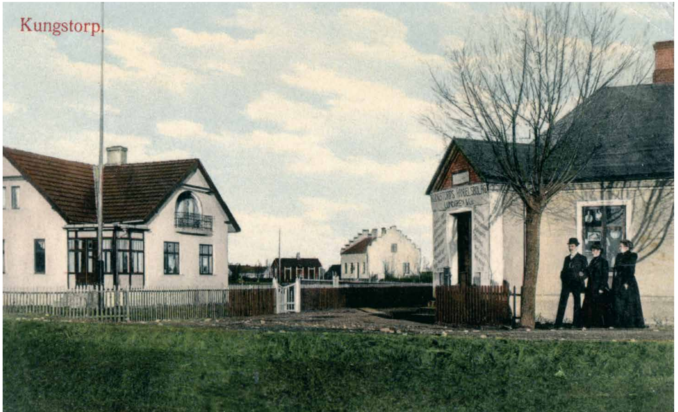
Kungstorps station låg där vägen från Vellinge till Stora Hammar och Räng passerade linjen. Hit fick man gå från byarna för att hämta post och tidningar. Störst aktivitet blev det på stationen under betkampanjen då många extravagnar skulle slussas ut på banan.
